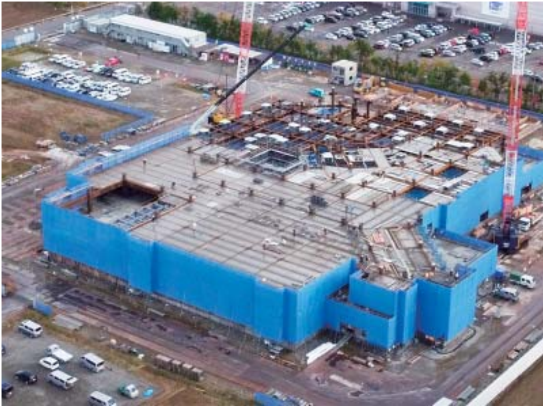
▲新病院建設工事の進捗状況 平成27年11月の状況
